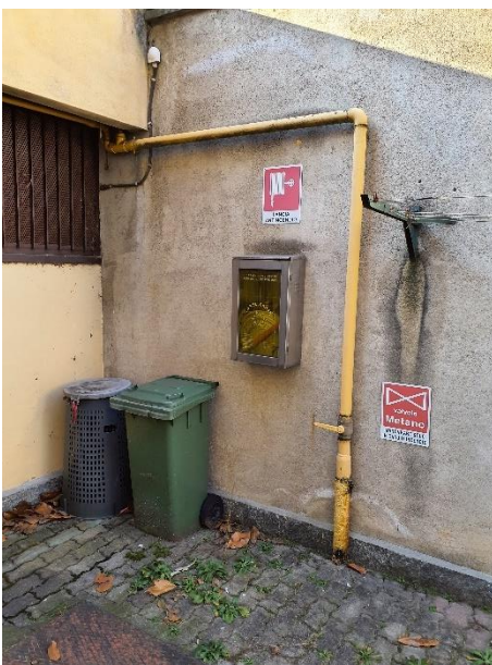
Tubazione e valvola zona centrale termica
